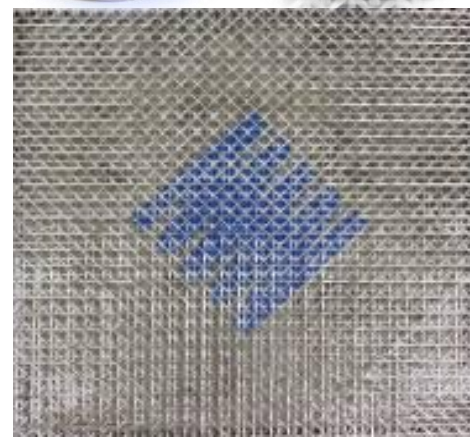
ガラス連続繊維シート貼付け
