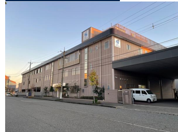
施工後 事務所・倉庫
