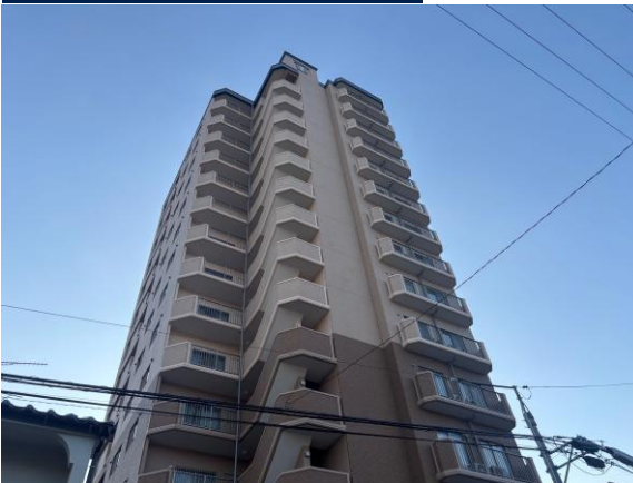
施工後 集合住宅
