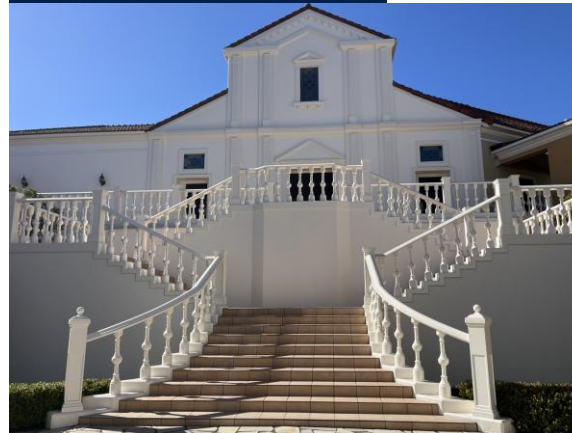
施工後 結婚式場
