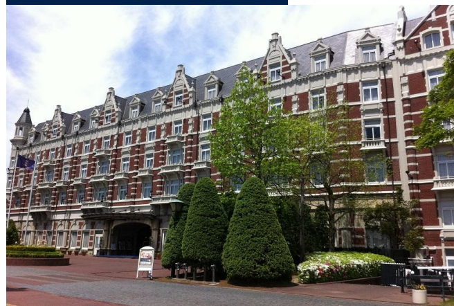
施工後 テーマパーク
