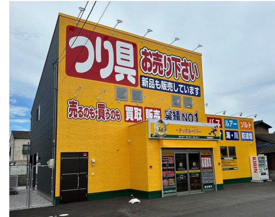
店舗新築工事
