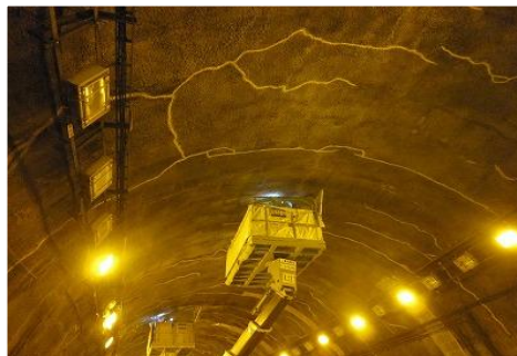
吹付けモルタルトンネル
