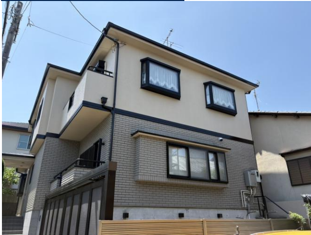
施工後 戸建て住宅
