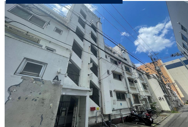
施工後 国有文化財
