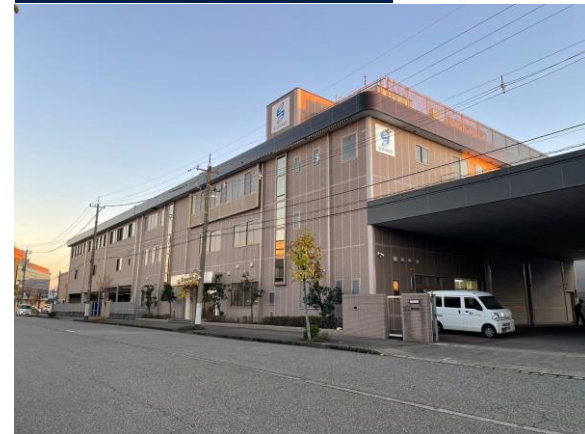
施工後 事務所・倉庫
