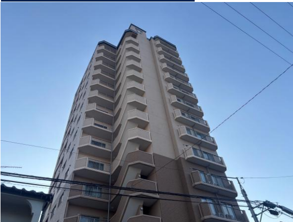
施工後 集合住宅
