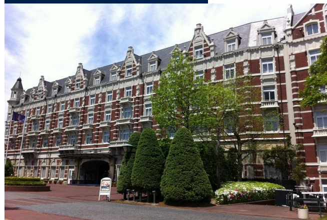
施工後 テーマパーク
