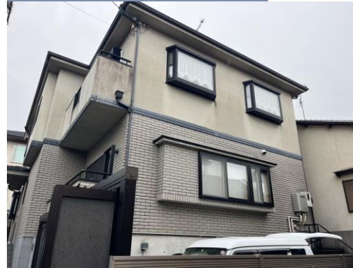
施工前 戸建て住宅
