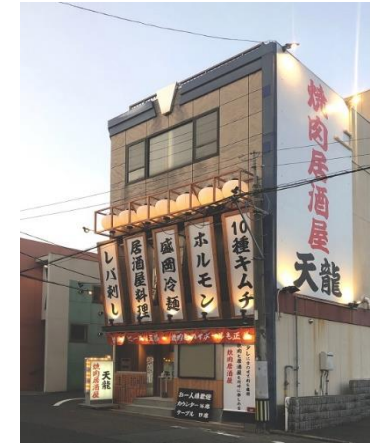
店舗新装工事
