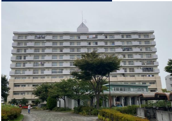
施工後 集合住宅
