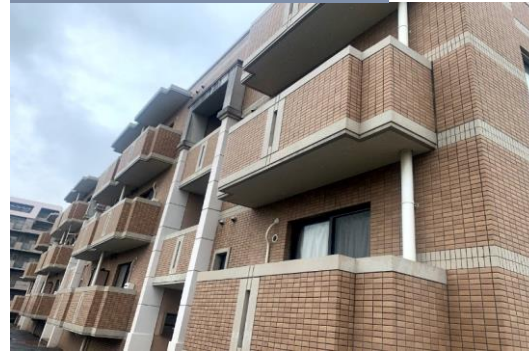
施工前 アパート
