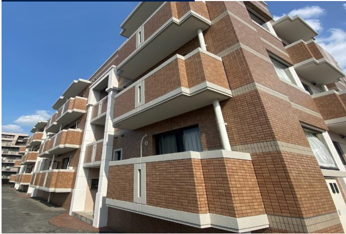
施工後 アパート
