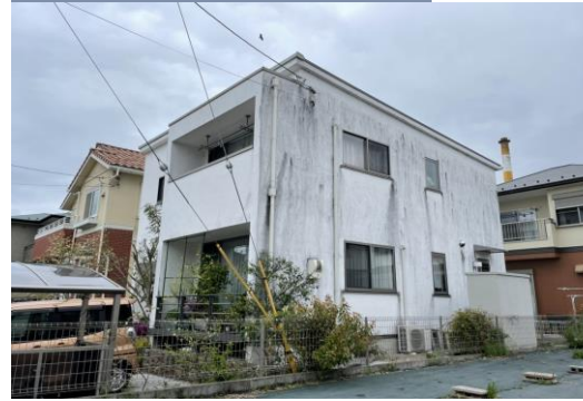
施工前 戸建て住宅
