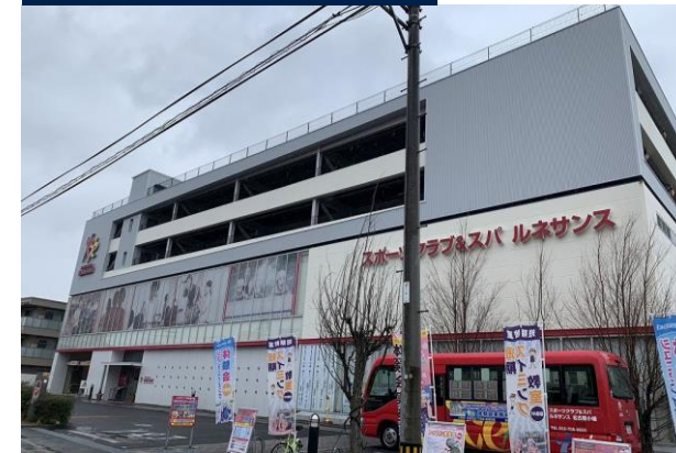
施工後 スポーツクラブ
