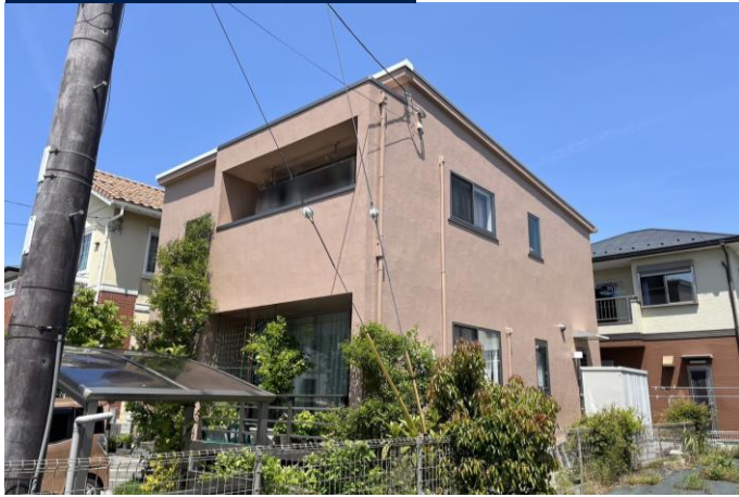
施工後 戸建て住宅
