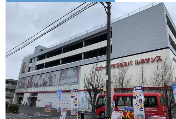
施工後 スポーツクラブ
