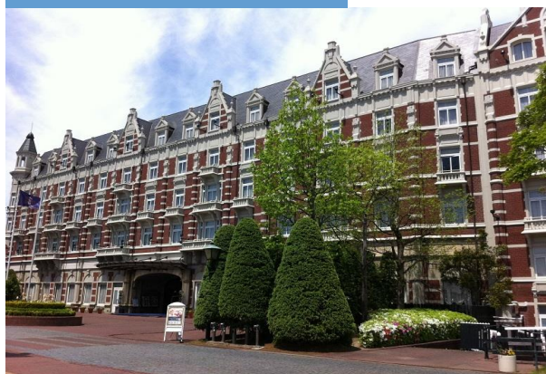
施工後 テーマパーク
