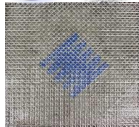
ガラス連続繊維シート貼付け
