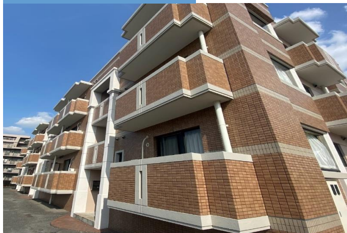
施工後 アパート
