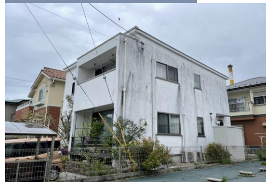
施工前 戸建て住宅
