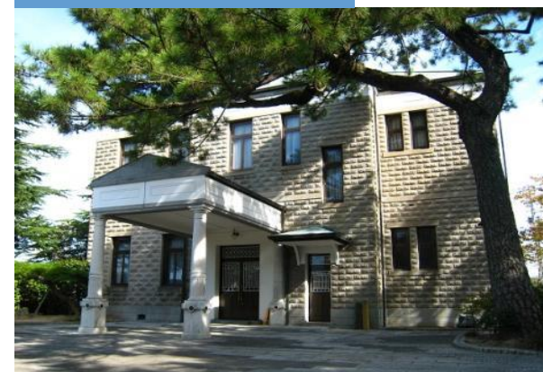
施工後 国有文化財
