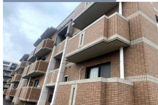
施工前 アパート
