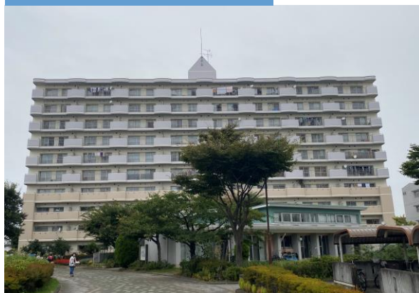
施工後 集合住宅
