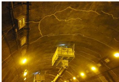
吹付けモルタルトンネル
