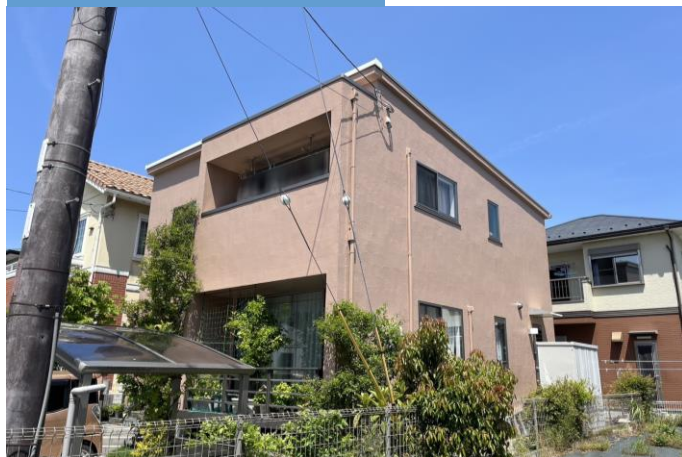
施工後 戸建て住宅
