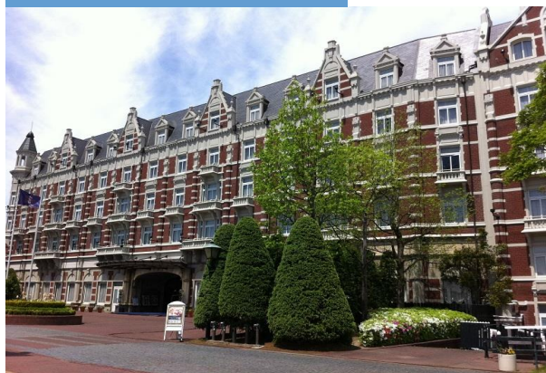
施工後 テーマパーク
