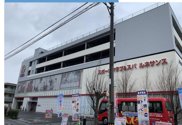
施工後 スポーツクラブ
