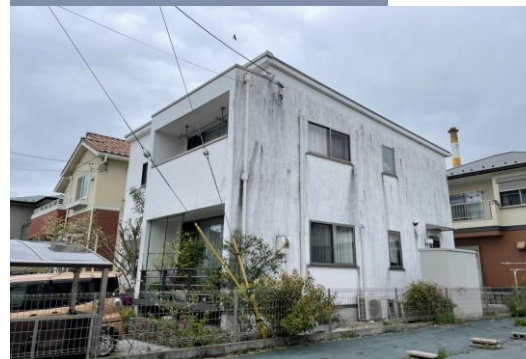
施工前 戸建て住宅
