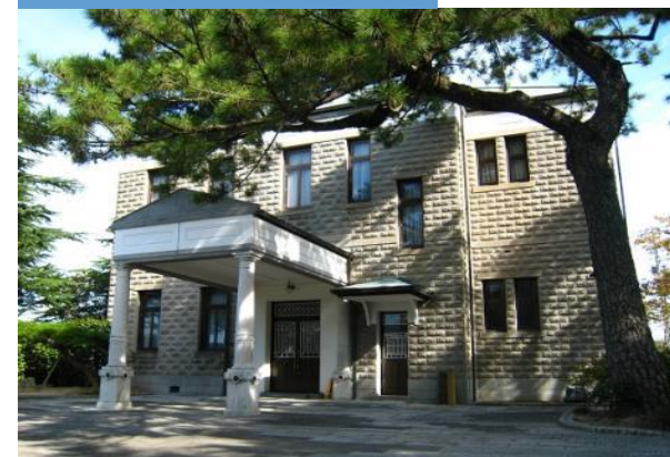
施工後 国有文化財
