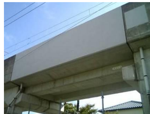
はく落防災コーティング
