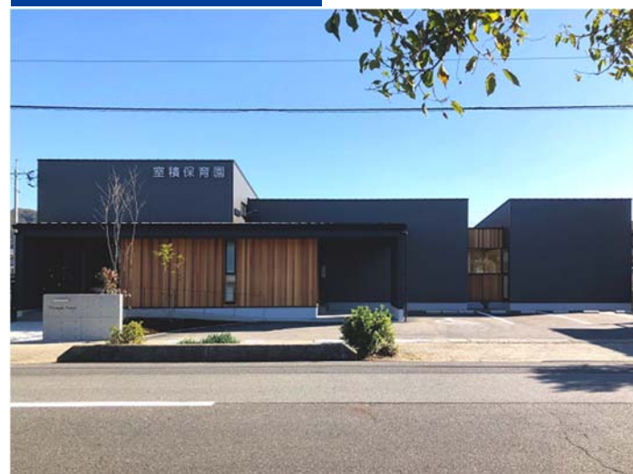
保育園新築工事
