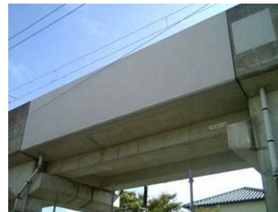
はく落防災コーティング
