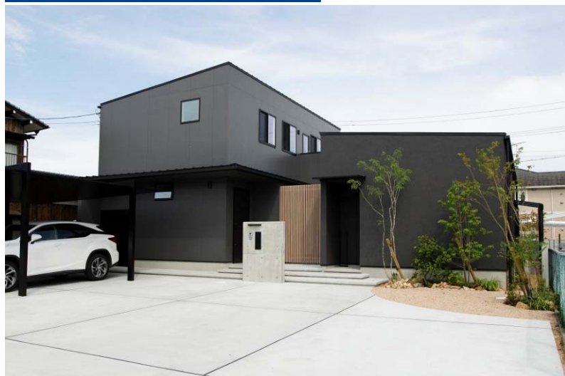
新築工事（戸建て住宅）
