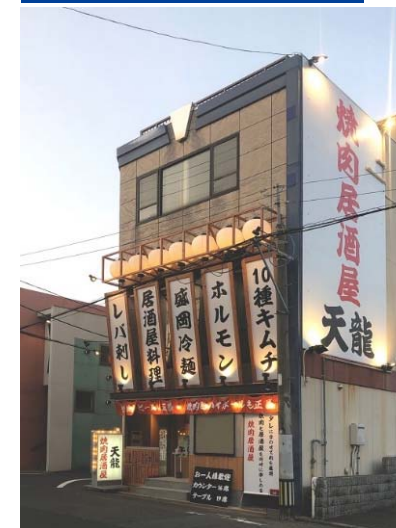
店舗新装工事
