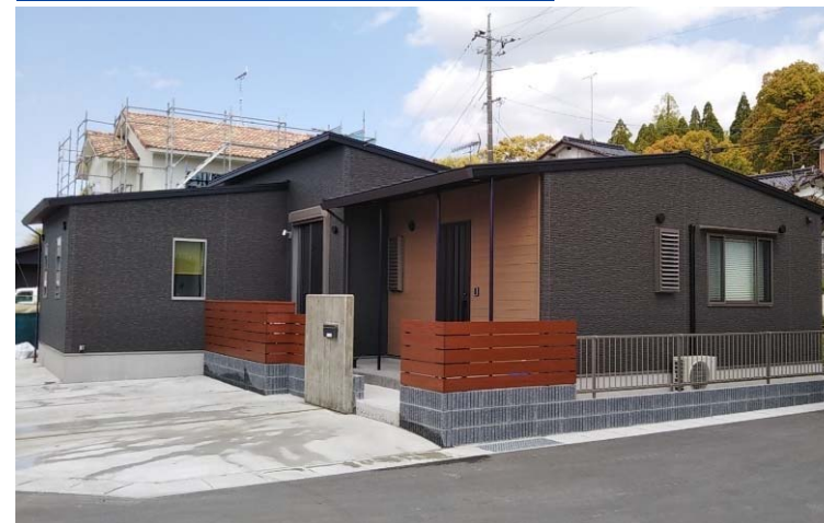
新築工事（戸建住宅）
