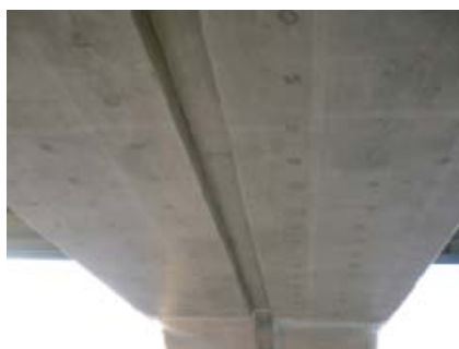
点検箇所の撮影
