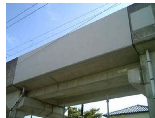
はく落防災コーティング
