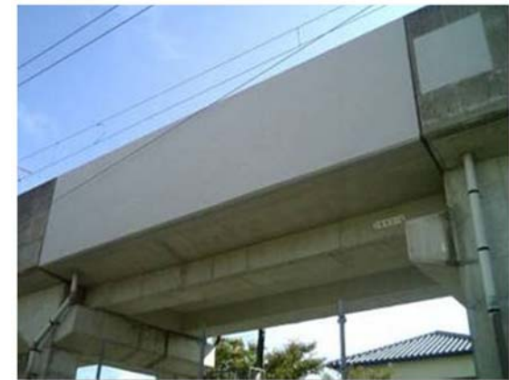
はく落防災コーティング
