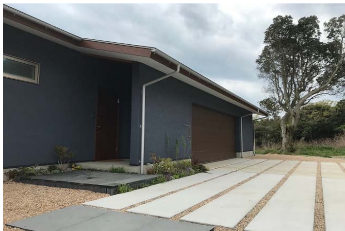
戸建て新築工事
