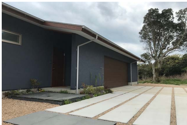
戸建て新築工事
