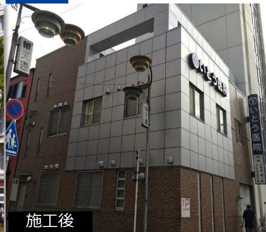
ヘアークラックや爆裂等の壁面の物理的な損傷に対して、追従（吸着・弾力）性と速乾性に優れた特殊な補修材にて強度を再生し、更にカラーコーティング材の塗布により美観も再生します。また、紫外線や酸性雨からの保護も実現します。
