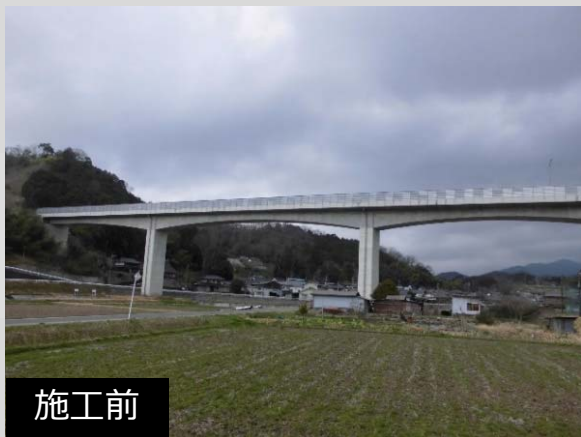
橋梁剥落防止工事 1,159m 2 (京都府)
