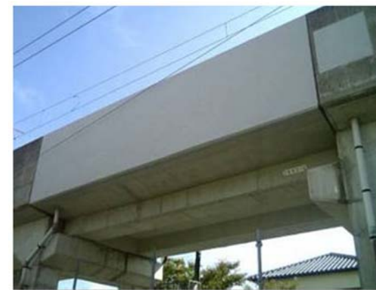
はく落防災コーティング
