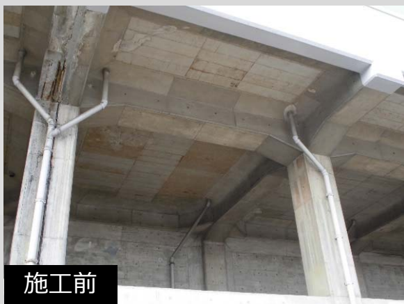
電車車庫剥落防止工事 659m 2 (兵庫県)
