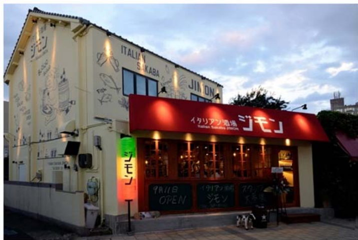
店舗改修工事（イタリアン酒場）
