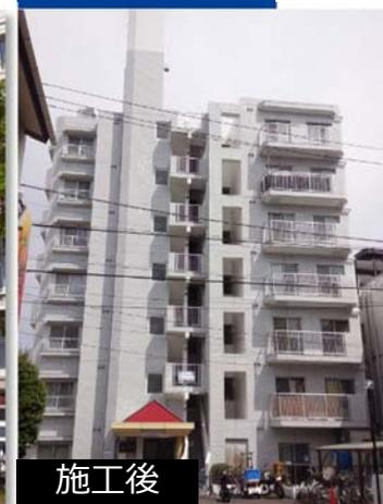
ヘアークラックや爆裂等の壁面の物理的な損傷に対して、追従（吸着・弾力）性と速乾性に優れた特殊な補修材にて強度を再生し、更にカラーコーティング材の塗布により美観も再生します。また、紫外線や酸性雨からの保護も実現します。
