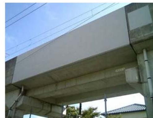
はく落防災コーティング
