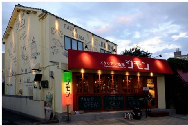
店舗改修工事（イタリアン酒場）
