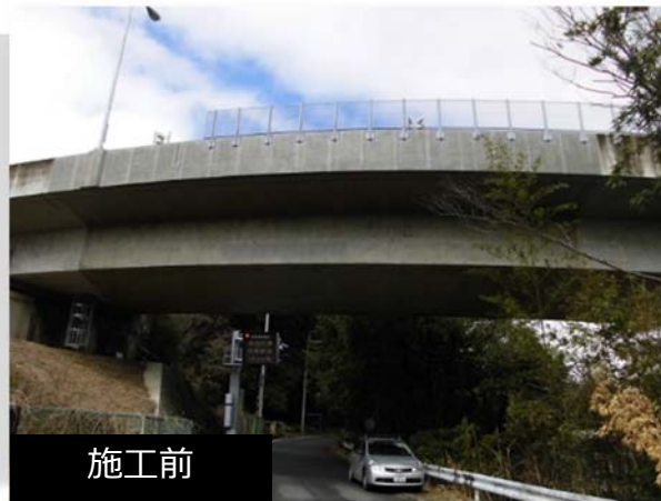
橋梁 剥落防止工事 645㎡ (京都府)
