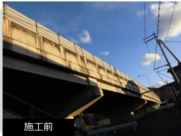
高架橋 剥落防止工事 578㎡ (兵庫県)
