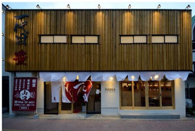
店舗改修工事（居酒屋）
