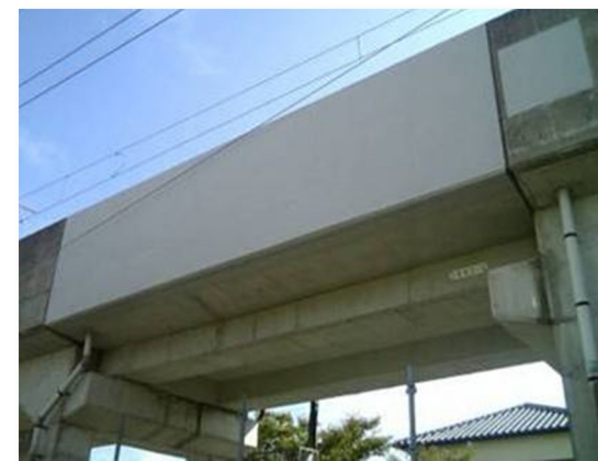
はく落防災コーティング
