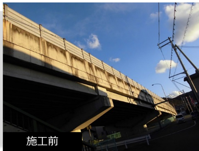
高架橋 剥落防止工事 578m 2 (兵庫県)
