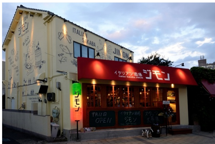
店舗改修工事（イタリアン酒場）
