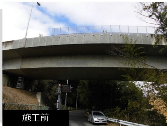
橋梁 剥落防止工事 645m 2 (京都府)
