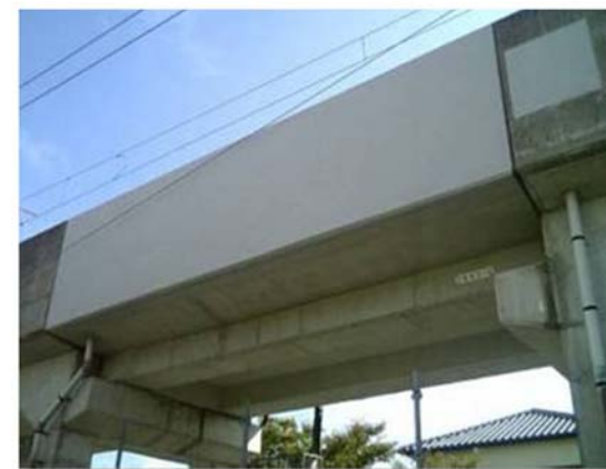
はく落防災コーティング
