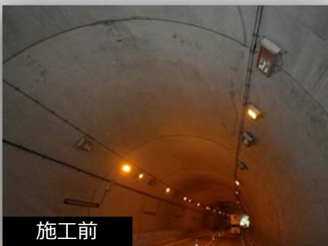
トンネル 剥落防止工事 254㎡ (山口県)
