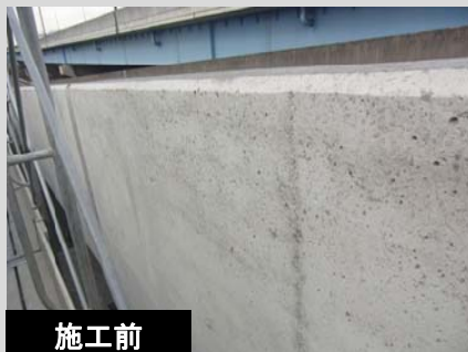
高架橋 剥落防止工事 324㎡ (東京都)
