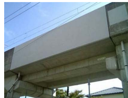
はく落防災コーティング
