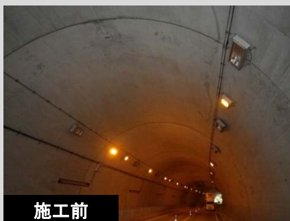
トンネル 剥落防止工事 254㎡ (山口県)
