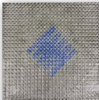
ガラス繊維シート貼付け・含浸
