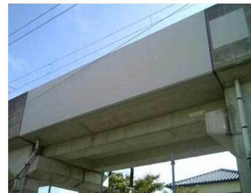
はく落防災コーティング
