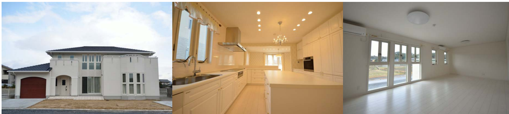
新築工事(住宅)
