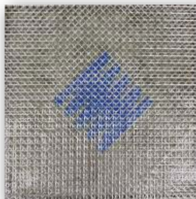
ガラス繊維シート貼付け・含浸
