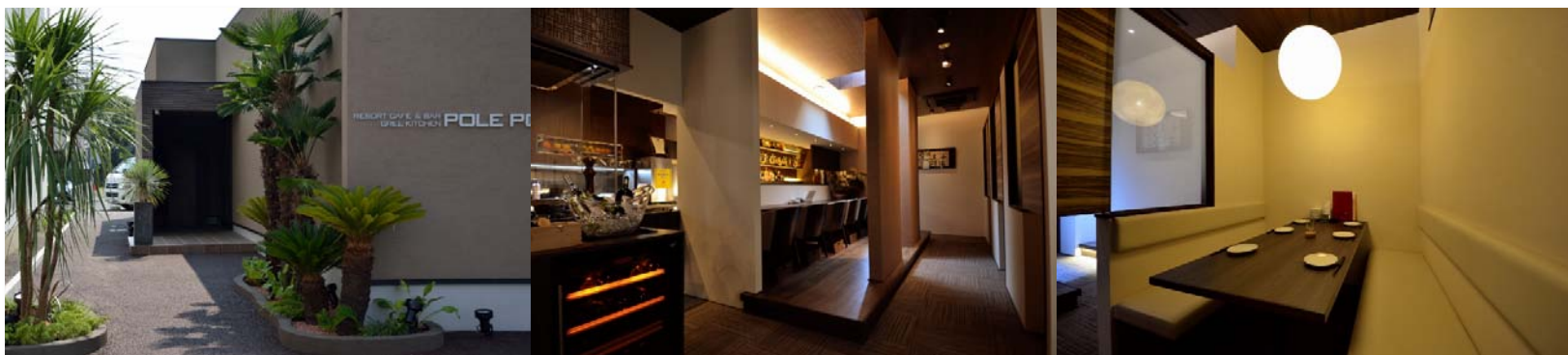
店舗新築工事(レストランカフェ&バー)
