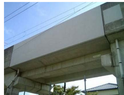
はく落防災コーティング
