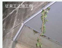
従来工法施工例
