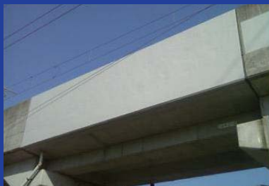
橋桁・橋脚・橋台、等
