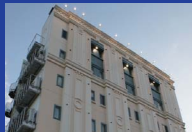
ALC・鉄骨造
