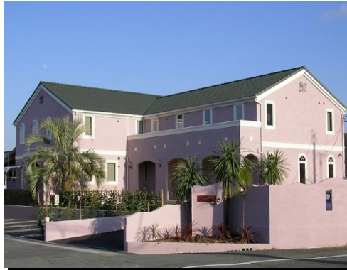
新築工事(エステサロン)
