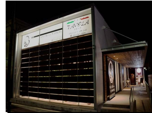
店舗改修工事(居酒屋)
