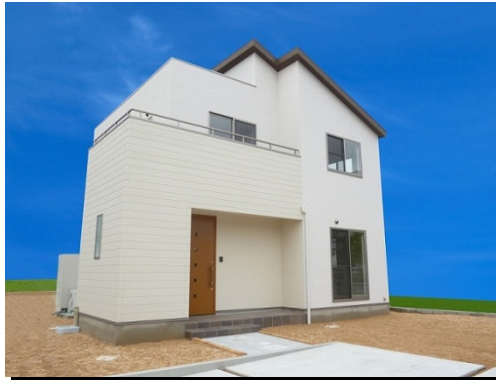
新築工事(住宅)
