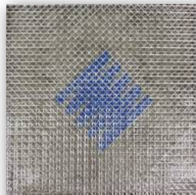
ガラス繊維シート貼付け・含浸
