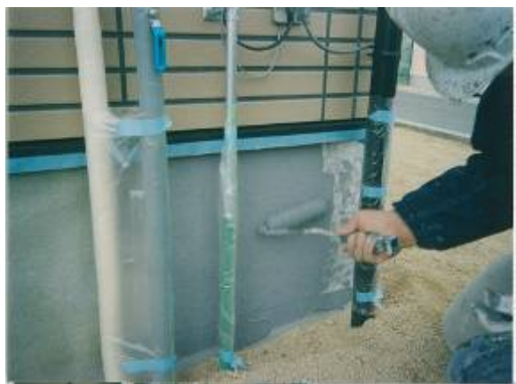
基礎クラック防止施工
