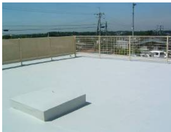
住居・ビル屋上の防水施工
