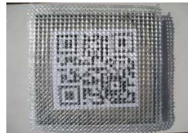
③ガラス繊維シートを置く
