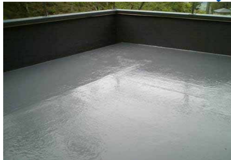
一般住宅(福岡県) バルコニー防水
