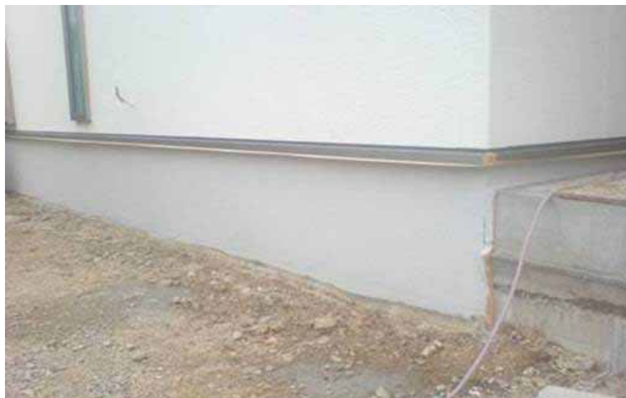
一般住宅(福岡県) 基礎コーティング
