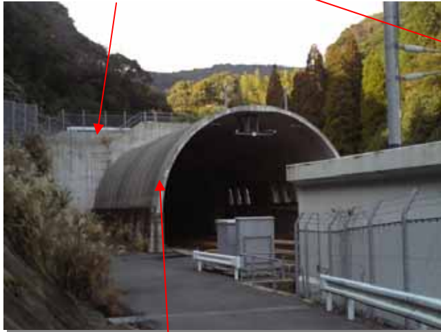
トンネル本工
