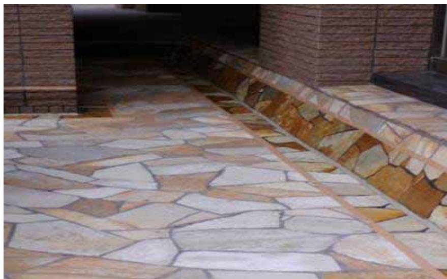
マンション(福岡県) タイル目地防水工事
