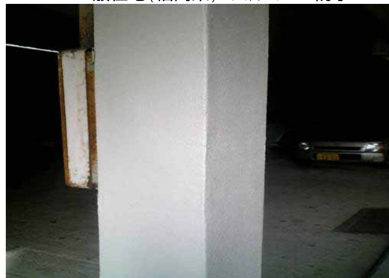
立体駐車場(福岡県) 梁補強
