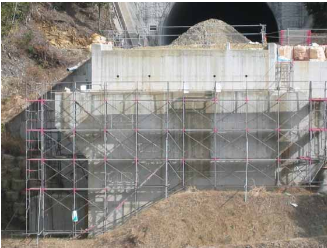
施工写真(全体)
