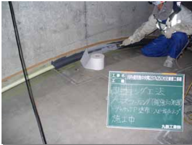
緩衝材のチューブに補強テープを貼り付けている様子
