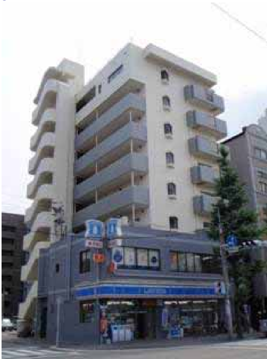
ビル(福岡県) リニューアル工事
