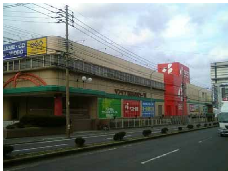
商業施設 (福岡県北九州市)
