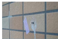
4 はく落防止ピン挿入
