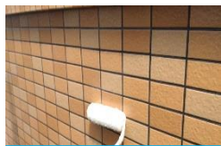
6 プライマー塗布
