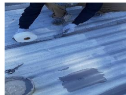
4 補強(ガラスファイバーマット処理・ヘビードューティテープ処理)
