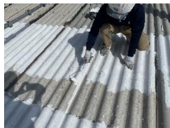
3 プライマー塗布(錆止め)
