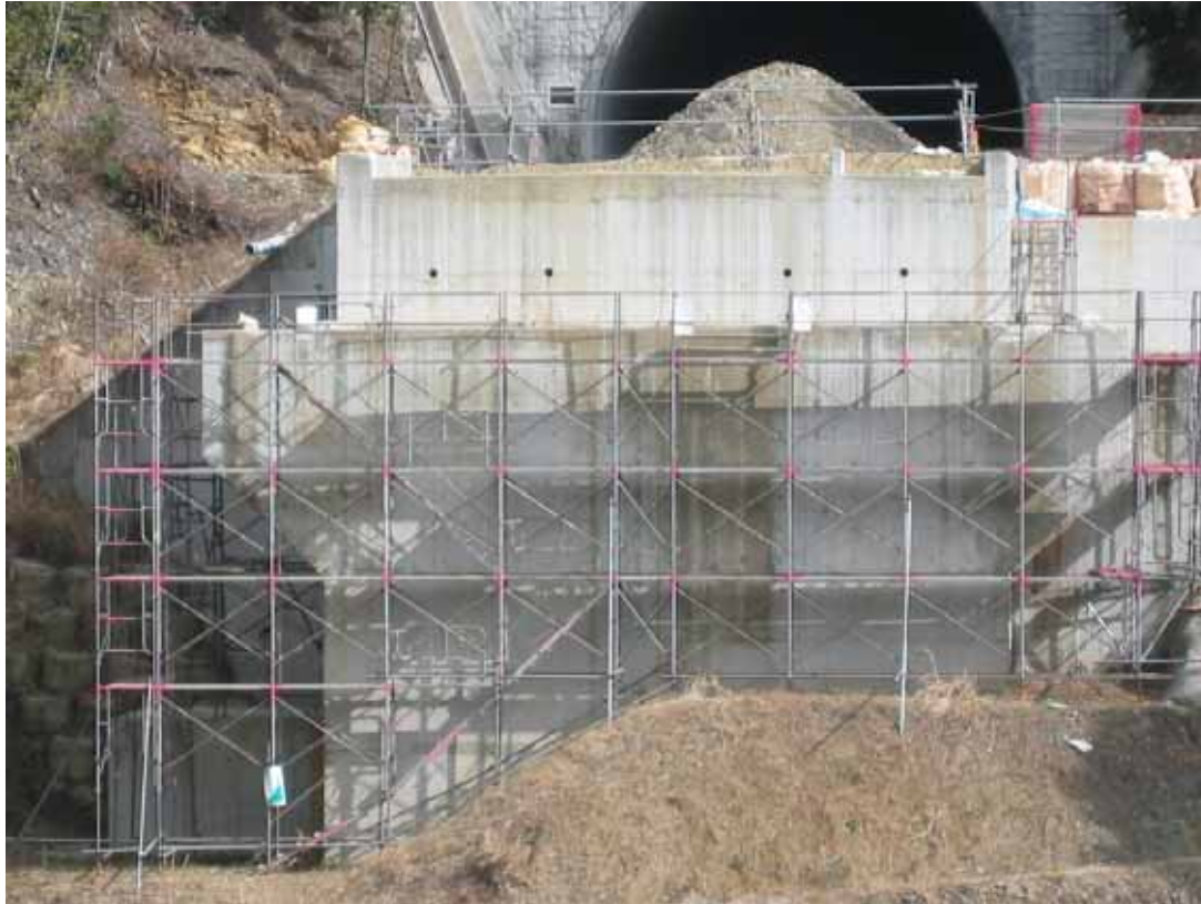
施工写真(全体)
