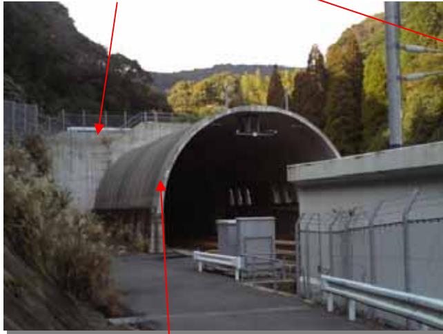
トンネル本工
